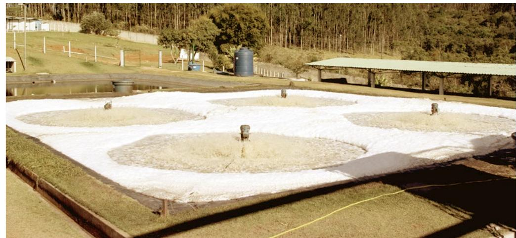
A ETE trata de forma qualificada os efluentes líquidos e, por isso, podemos utilizar também como produto de fertirrigação. Esse processo se constitui basicamente em irrigar as áreas de jardinagem e área verde com o efluente líquido já tratado, conforme temos a autorização junto ao órgão ambiental e realizar monitoramento.
